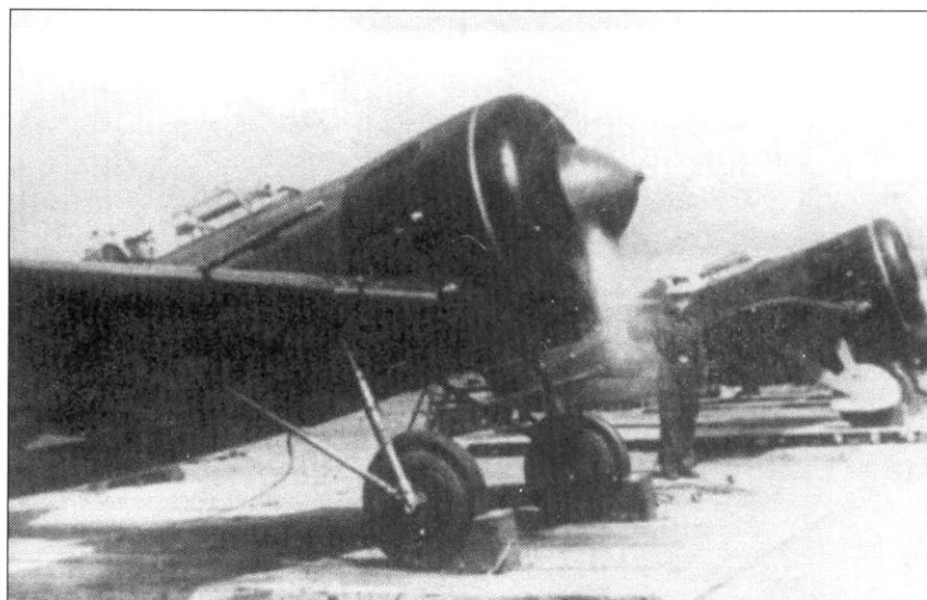
И-16 тип 5 одного из авиаполков ВВС военно-морского флота, снимок 1939 г. Обратите внимание - у истребителя на переднем плане отсутствуют щитки основных опор шасси.
